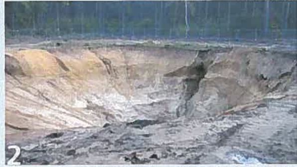
2 Aushubtrichter mit max. Tiefe von 11,5m
